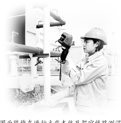
图为陈梅在进行主变本体及架空线路测温
