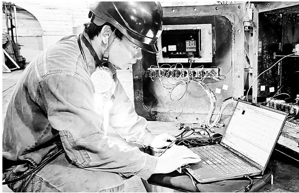
3月27日,永安煤业公司仙亭煤矿聚焦智能化建设与科技保安,顺利完成沿线急停保护装置在线监测及防逆转保护升级改造,以技术创新全面提升安全保障能力,为矿井安全生产筑牢坚实防线。图为厂家技术人员修改PLC程序。
