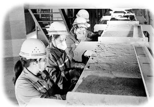
图为女职工在A组8322长皮带安装护皮
