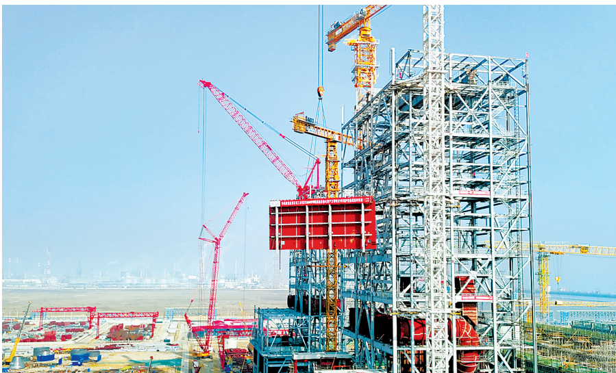
3月18日8时30分，东桥热电公司泉惠石化工业区2×660MW超超临界热电联产项目迎来关键节点——1号锅炉首件受热面组合件顺利起吊并精准就位。此举标志着项目锅炉本体安装工作正式拉开帷幕，热电联产工程建设迈入全面提速的新阶段。（张超/文 吴秀娜/图）
