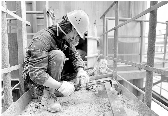
12月22日,福维公司钙化物厂顺利完成螺锥出灰室筛条专项技术改造,以小投入一举解决制约系统稳定运行的突出问题。今年以来,该公司坚定不移走技术创新之路,组织各专项攻关小组开展设备、工艺技术攻关,多项小改小革已在各生产环节推广应用并取得成效。(吴嘉悦 摄)
