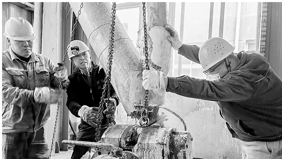
目前,维纶改性纤维市场热销,福维公司紧跟市场需求,在精心组织生产的同时,抓好关键设备备件维修,实行设备“轮岗”管理,确保生产稳定,产品及时供应到位。图为11月20日,该公司维纶厂检修人员利用午休时间更换凸轮器。(张发炜 摄)
