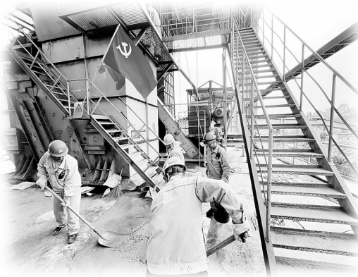
图为示范岗党员搅拌浇注料
