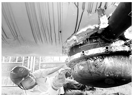
图为维修人在修复疏水罐
