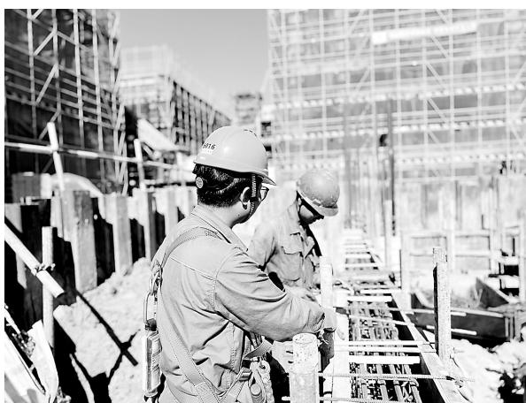
▲ 9月12日,古雷热电公司工程建设部牵头组织各参建单位,正式启动月度安全检查暨“控风险 除隐患 防事故”百日攻坚专项检查工作。图为检查人员询问建设人员安全知识。(林传峯 摄)
