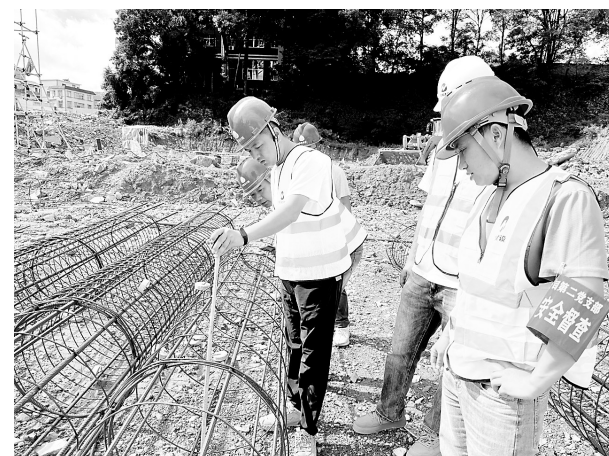
▲ 联美公司德化笔石山项目以“质量月”活动为契机,全面有序推进质量提升工作。9月15日,项目团队深入施工一线,严格落实工序质量控制要求,强化全过程质量监督,切实保障工程实体质量。(徐宗鹭 摄)
