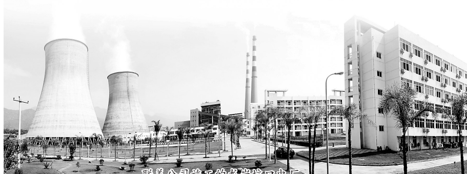
联美公司施工的龙岩坑口电厂。
