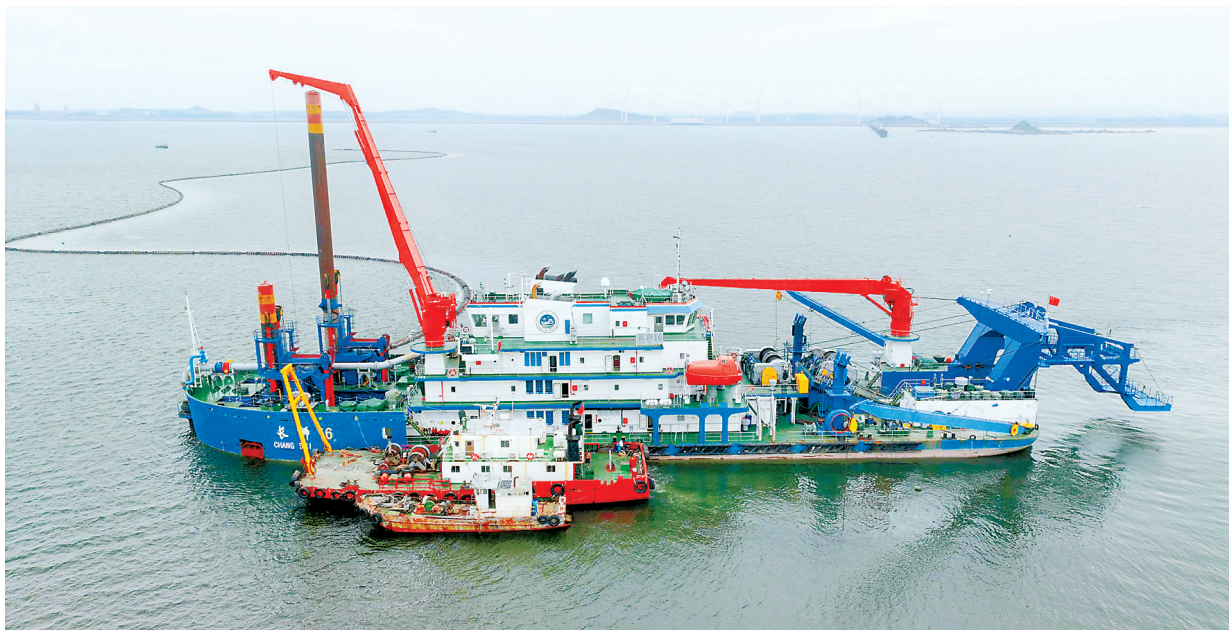
9月3日,随着一艘现代化的大型3500立方米/小时绞吸式挖泥船开启高效清淤作业,东桥热电码头工程项目迎来关键节点——疏浚工程正式开工,项目全面进入实质性施工阶段,为后续码头主体结构施工奠定了坚实基础。(东桥热电 摄)
