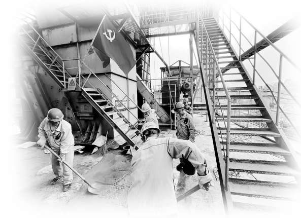
图为示范岗党员搅拌浇注料
