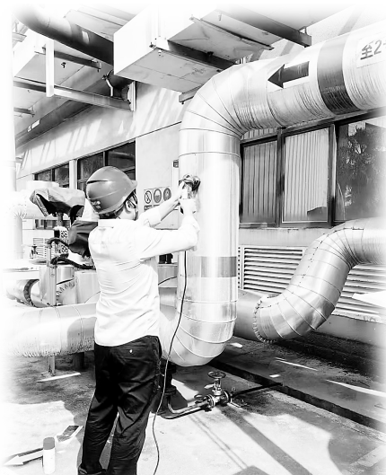
图为陈嘉锡清除破损管道标识
