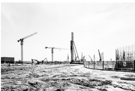
东桥热电主厂房#1#2锅炉基础施工现场
