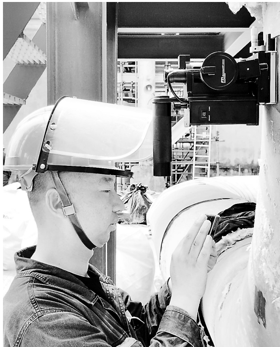
夏日炎炎,烈日当空。近日,在福海创公司大检修现场,专业检验人员顶着高温,全力投身压力容器、压力管道定期检验工作。(徐志鹏 摄)
