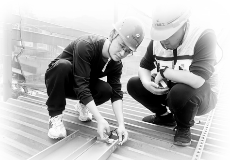
图为林东来(左一)用千分尺测量桥梁厚度
