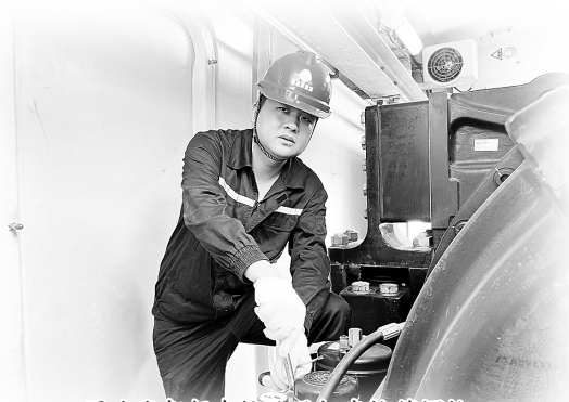
图为张智超在校验风机齿轮箱螺栓
