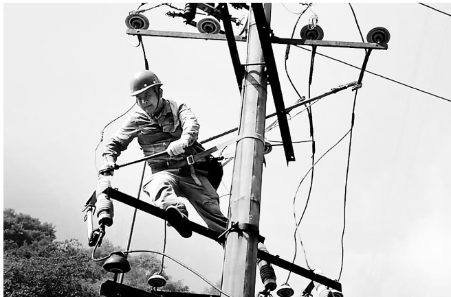
6月9日深夜12时许,龙潭风井II进线杆B相避雷器被雷电直接击穿。福建煤电电力安装检修公司接到警报后于10日组织抢修人员奔赴现场,经过1个多小时紧张作业,成功恢复风井供电及监控系统运行。(陈先英 摄)
