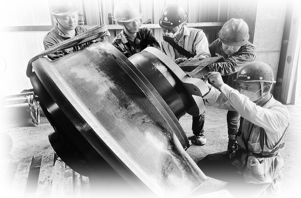
图为徐福坡(右一)和维保人员在中细碎车间检修圆锥破碎机
