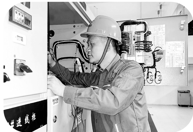
图为赖育顶在进行10kV开关柜定检
