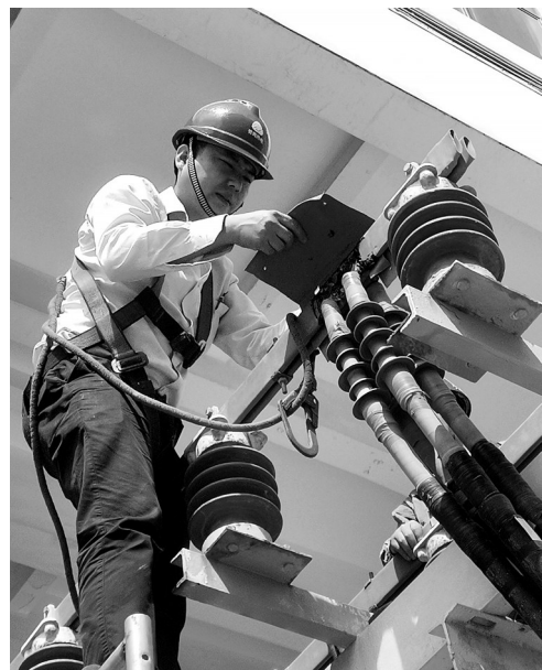
►晋南热电公司生产现场,五一期间的劳动节奏丝毫不变,检修与运行员工仍然坚守在各自岗位。图为电气专业负责人在检查主变绝缘子。(周国利 摄)
