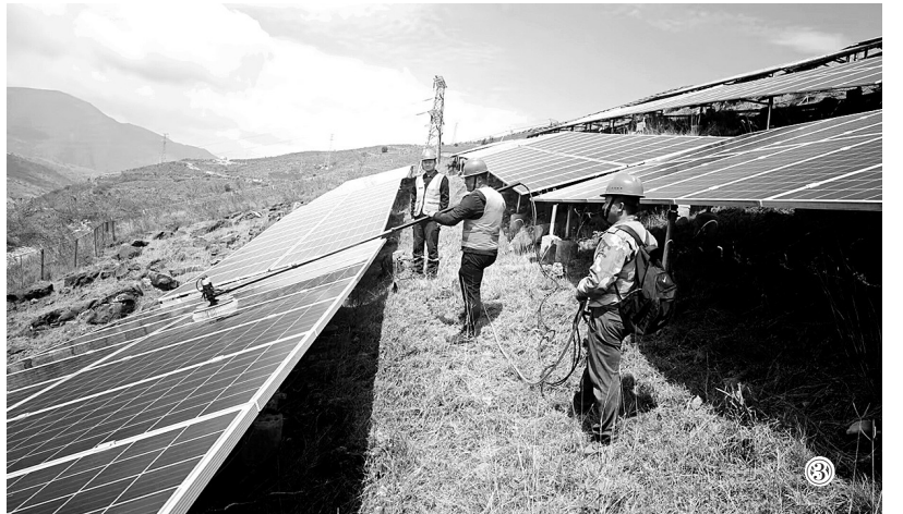
③福能新能源公司成功试验新工艺,实现光伏组件发电效率3%的提升,全面推动企业提质增效进程。图为近日,该公司云南管粮山光伏电站以“高压冲洗+旋转刷洗+纳米镀膜”工艺开展光伏组件增效研究。(蒋文君 杨赛 摄)
