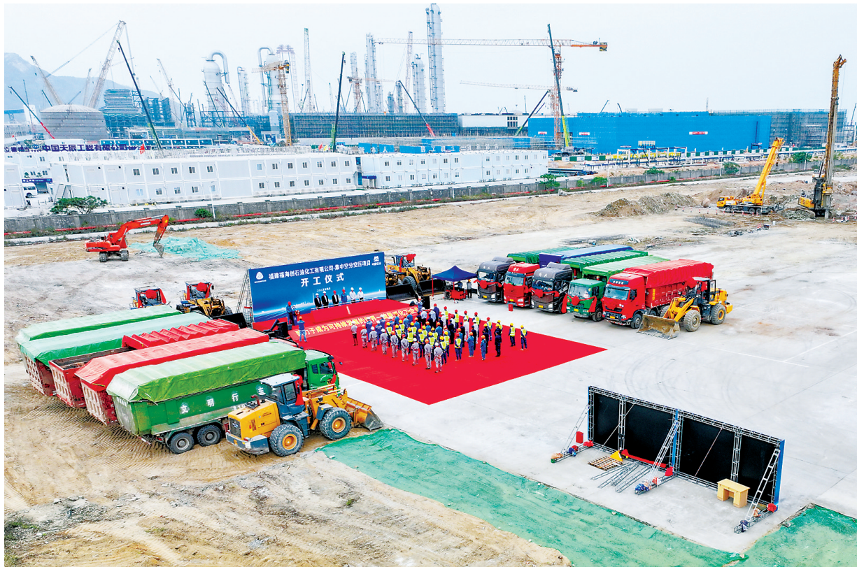
4月18日,福海创集中空分空压项目开工仪式在漳州古雷石化基地举行。福海创集中空分空压项目是福建能源石化集团“十四五”规划的重要一环,项目采用国际领先的空分技术,致力于为古雷石化园区提供高效、稳定的工业气体供应。项目建成后,将显著提升园区产业链的协同效应,满足中沙古雷乙烯项目及周边企业对原料和公用工程的需求,进一步推动古雷石化基地向高端化、绿色化、集约化方向发展。(福海创摄)
