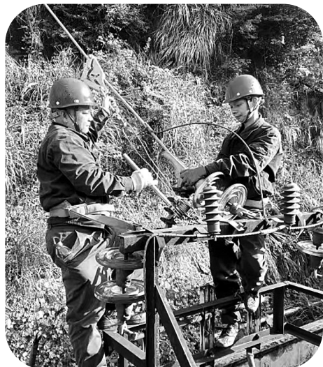
▲福建煤电电力安装检修公司持续通过“节支降耗、修旧利废”等办法,全方位补齐电网短板,进一步提升电网输电稳定性。图为近日,维修技术人员在处理龙潭II线出线接触面氧化问题。(张建安 张萍 摄)
