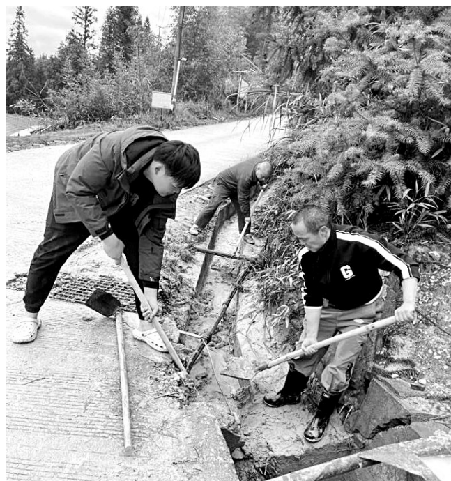
持续降雨过后,浦城矿业公司临江浮选厂厂区水沟堆积了大量淤泥和杂物,影响排水能力。为消除隐患,该厂组织员工清理水沟,经过数小时奋战,厂区内水沟被清理干净,排水恢复畅通。(吴雨茜 摄)
