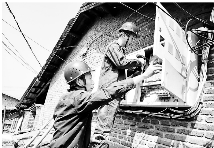
近期,福建煤电电力安装检修公司▲建专班,对陆家地煤矿生活区开展智能电表更换工作。此次改造覆盖生活区全部楼栋,新装电表具备远程抄表、线上缴费等功能。图为3月25日工作人员正在安装智能电表。
