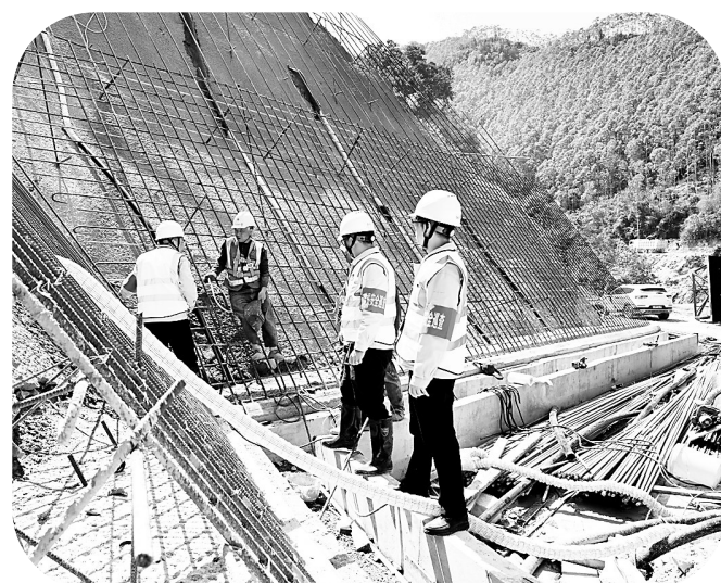
花山抽蓄项目深化党员先锋工程建设,组建党员安全“红袖章”,深入施工现场加强安全督查。图为3月19日,党员“红袖章”正在“两洞一路”进行安全督查,保障施工现场的安全,确保工程顺利推进。(连益峰 摄)
