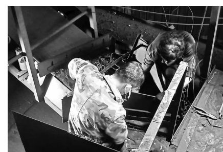
近日,福建煤电雁石发运站迎来了一项重要的技术革新——大圆滚筛皮带更换三角犁头牛筋护皮。这一创新举措标志着雁石发运站在设备优化和生产效率提升领域取得了实质性的进展。
