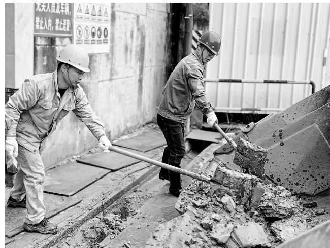
3月6日,为预防强对流天气,建材控股永定公司组织职工进行厂区水沟清理,确保公司区域内排水系统正常运行。(吴津 摄)
