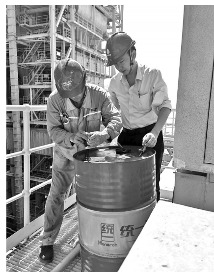
图为电气点检人员和检修人员检查备用变压器油。
