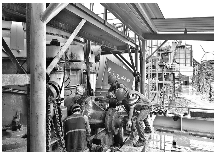
近日,福能新材权属漳州公司矿山中碎车间1#圆锥破碎机突发故障。公司上下闻令而动,支部党员先锋队第一时间赶赴现场展开紧急抢修,历时10余小时的连续奋战,顺利完成了抢修复产工作。(王志山摄)
