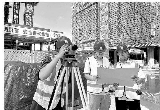
国庆期间,联美公司德化许厝第三工程项目部建设者们坚守岗位,开足马力抢工期。图为现场施工员正在精准放样中。(郑思瑶 叶小强 摄)
