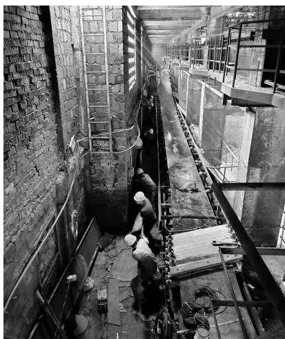
福建水泥顺昌炼石熟料分厂对物料输送皮带进行更换,确保国庆长假期间物料供应的顺畅无阻。(蔡桂旺 摄)
