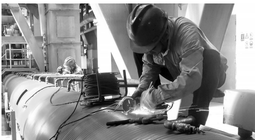
国庆期间,晋南热电公司检修人员利用生产运行间隙,见缝插针更换、加固锅炉输渣皮带护罩。(周国利 摄)
