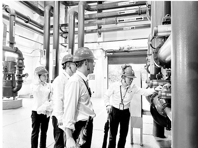
▲ 国庆将至,为全力保障机组在节假日期间安全稳定运行,9月24日下午,鸿山热电设备维护部党支部开展国庆节前安全检查。图为设备隐患排查现场。(卢建隆 摄)
