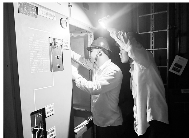
▲ 9月9日,福能新能源顶岩山风电场B组集电单元突发故障,检修人员第一时间赶赴现场对故障设备进行排查,昼夜抢修保供电。图为检修员连夜抢修顶岩山风电场#10风机环网柜。(林剑辉 林伟雄 摄)
