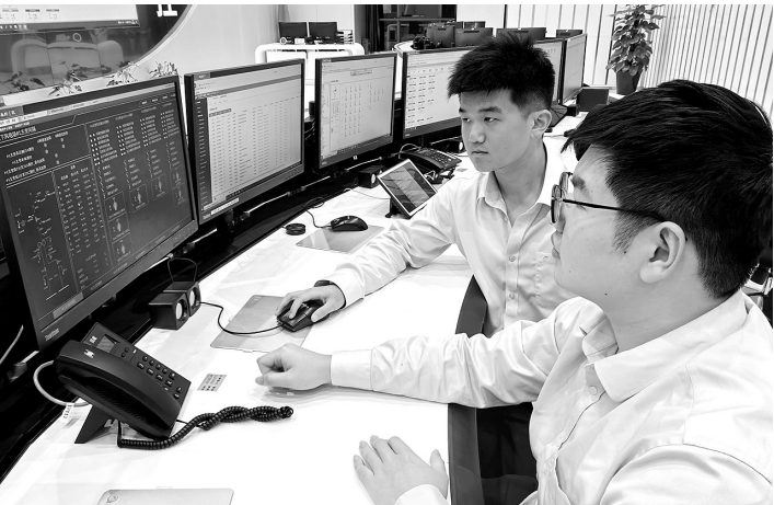
中秋佳节,福能海峡公司生产人员以高度的责任感和无私的奉献精神,默默坚守在保电一线。图为智慧海电中心的值班员们紧盯设备运行状态,做好各项应急预案。(海峡 摄)
