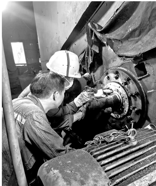
中秋佳节,福建煤电公司坎市发运站开展拉网式安全隐患排查,确保节日期间生产安全稳定运行。(林玉梅 摄)
