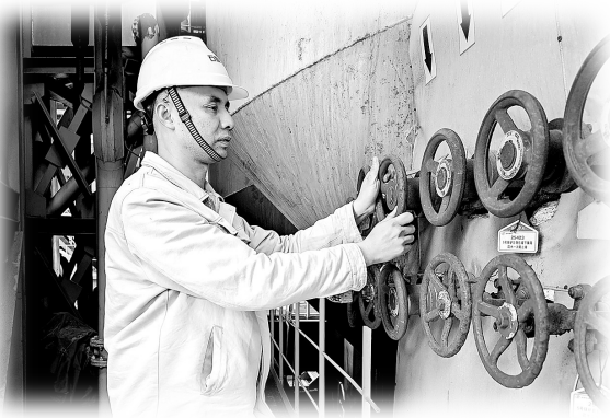
图为陈树山在做点火前阀门开关试验工作
