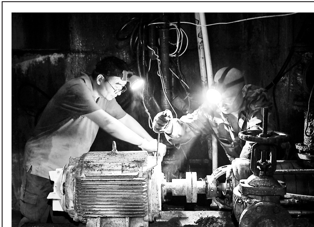
▲9月8日，为加快恢复西湖山、红一矿60多户住户居家用水，福建煤电红炭山物业站抢修队员们放弃午休，连续奋战6小时，确保职工家属在晚饭前可以正常用水。图为该站工作人员在水泵房更换水泵电机轴。（郑延玲 谢龙辉 摄）
