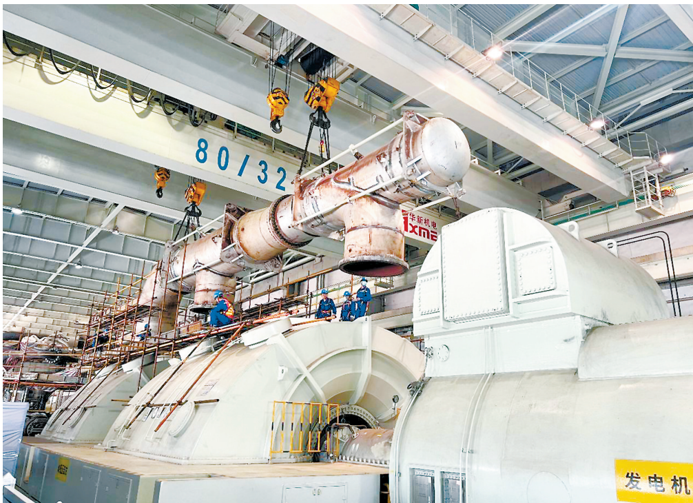
8月24日中午12点，福能贵电#1机中低压连通管缓缓升起，标志着该公司汽轮机本体检修战役正式打响。(冉川洲 彭刚 摄)
