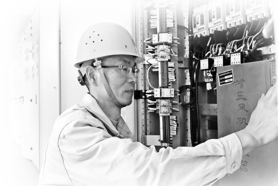
图为陈清彪正在对钙化物项目破碎給料系统加装变频器
