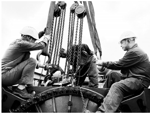
7月15日,炎炎夏日,福能新能源公司顶岩山风电场利用短暂的小风天窗口期,更换#01风机齿轮箱,保障发电效率。(林强 卢毅越 摄)
