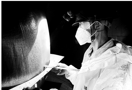
7月5日,鸿山热电公司检修人员在闷热的有限空间内对1E磨煤机磨辊磨损情况进行测量和记录,为后续磨煤机磨辊堆焊工作提供数据支撑,确保顺利开展预防性检修工作。(黄荣 摄)
