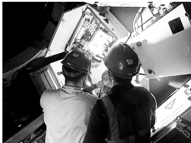
▲ 针对风机变桨系统故障频繁、电量损失大的问题,近日,福能新能源公司隆教风电场组织人员对风机变桨系统进行直改交技术升级改造,为风电机组安全稳定运行提供有力保障。新变桨系统投入运行以来,有效减少了风电机组故障次数,提高了安全性和发电效率。(李银华 摄)
