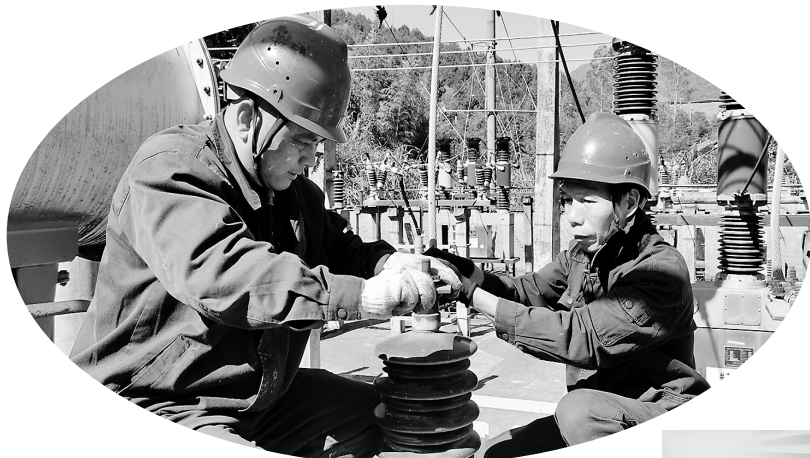
7月1日,福建煤电电力安装检修公司维修车间工作人员顶着高温,对35千伏铜锣坪变电站主变设备线夹异常进行消缺,确保电网稳定运行。(张萍 摄)
