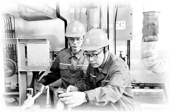
图为江建清(右)带领徒弟处理机组调速系统伺服阀故障
