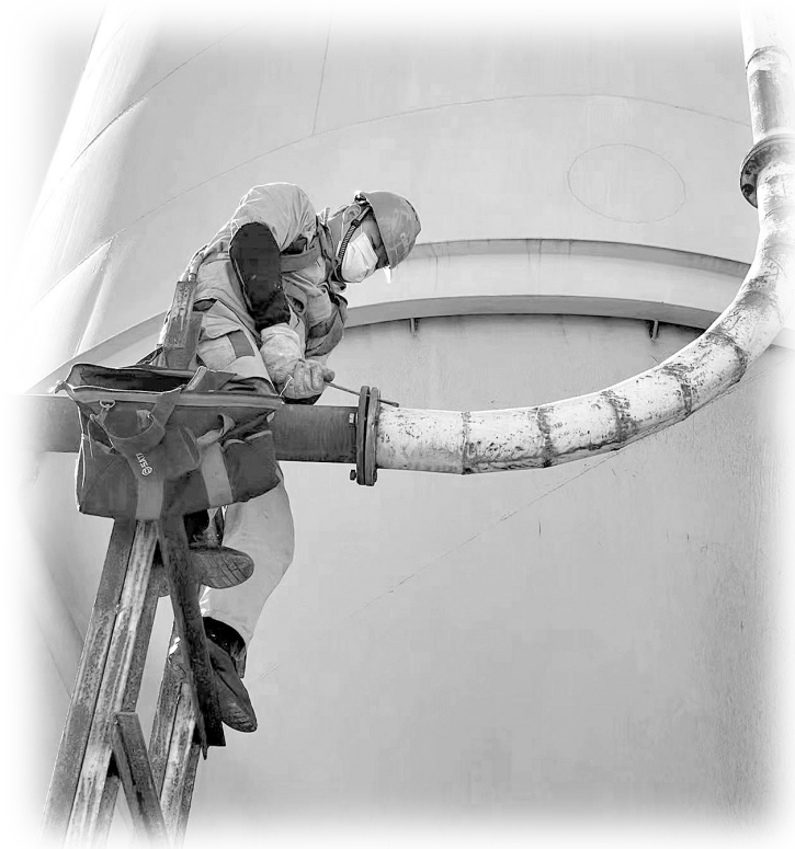
图为陈志渊在处理锅炉输灰管道泄漏
