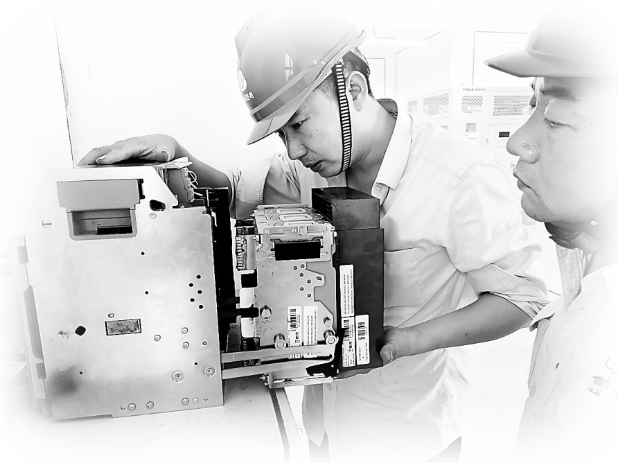
图为陈志群(左)正在检修现场检查故障断路器
