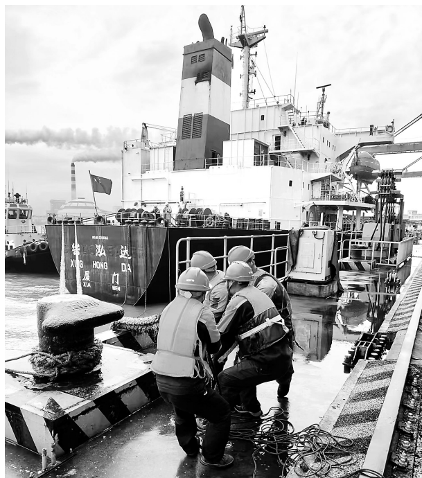
5月1日,福建煤电泉州分公司在遭遇连续半月暴雨、大雾天气的影响下,为确保电煤转供,全体员工坚守岗位,凝聚合力、踔厉前行,实实在在抓好“五一”期间生产安全工作。图为轮船靠岸时保洁人员正在系缆绳。(赖春平 摄)
