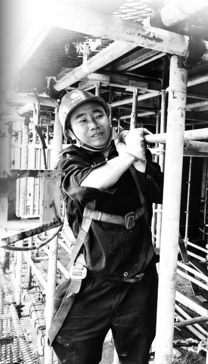
联美第一分公司职工在德化·美伦云启上城一期项目部2#塔吊安装附着装置。(叶智兴 摄)
