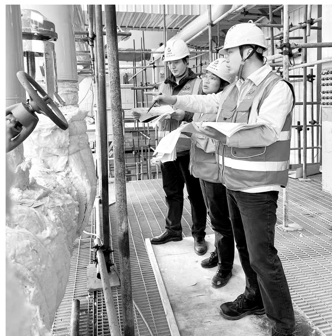
▲ 3月6日，龙安热电公司汽机专业及锅炉专业分别邀请设备厂家为该公司运行人员讲解操作知识及要点。（范金明 摄）
