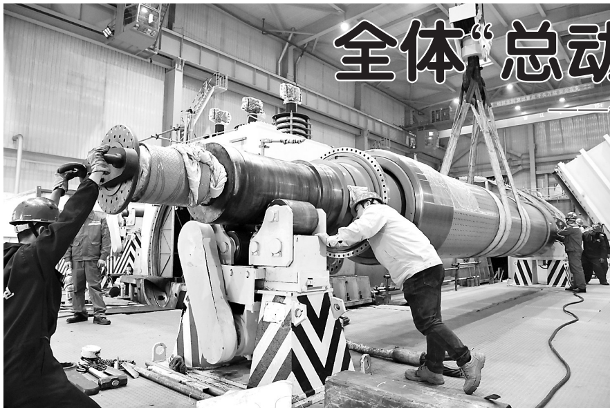
检修人员正调整发电机转子落座角度。(王素环 摄)
