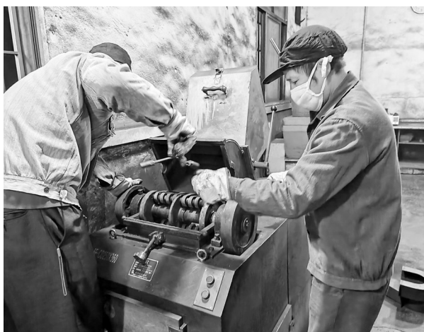
图为该站机修人员正在对制样室设备进行日常巡检
