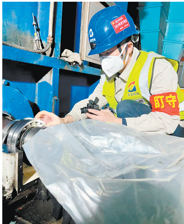
▶岁末寒冬,冷风萧瑟。龙安热电公司春节检修现场,一幅热火朝天的检修画卷正在徐徐展开,奋战在一线的热电人尽职尽责,正在努力打造精品检修工程。图为近日检修人员进行风机轴承检查。(涂瑞兴 摄)
