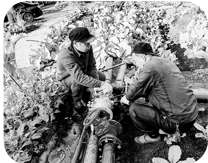
为保障冬季供水稳定,近日,福建煤电公司坎市发运站对站区供水管道进行维护保养,全力做好冬季供水保障工作。图为机修人员正在更换生活区主管道。(陈凯迪 摄)
